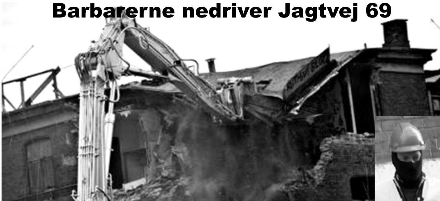
Jagtvej 69 blev jævnet med jorden af maskerede, politibeskyttede nedrivningsarbejdere
